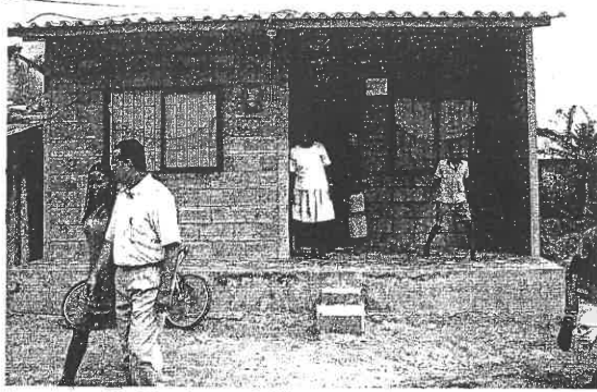
Una de las 40 viviendas construidas con ayuda navarra en Apartadó.
