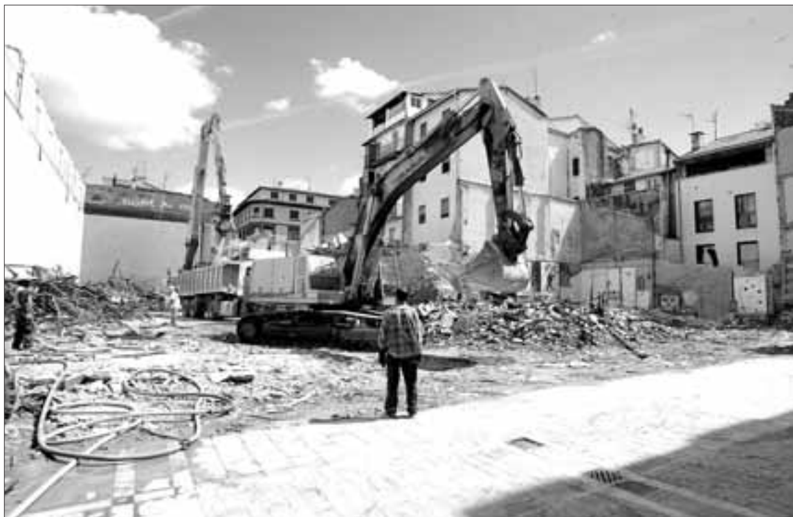
Las excavadoras trabajaron ayer en la retirada de escombros, con el frontis (al fondo) todavía en pie.
