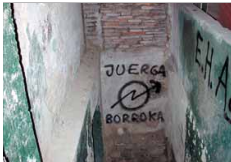
ENTRADA A UN ZULO. Dentro de este zulo se encontraban tres jóvenes con sus brazos metidos en tubos que se unían a una antigua caldera. Contaban con pequeños orificios en la pared para poder respirar.
